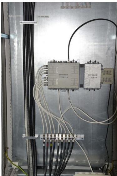
Abbildung 3: Multischalter (links) und Satellitenempfänger (rechts) im Labor
